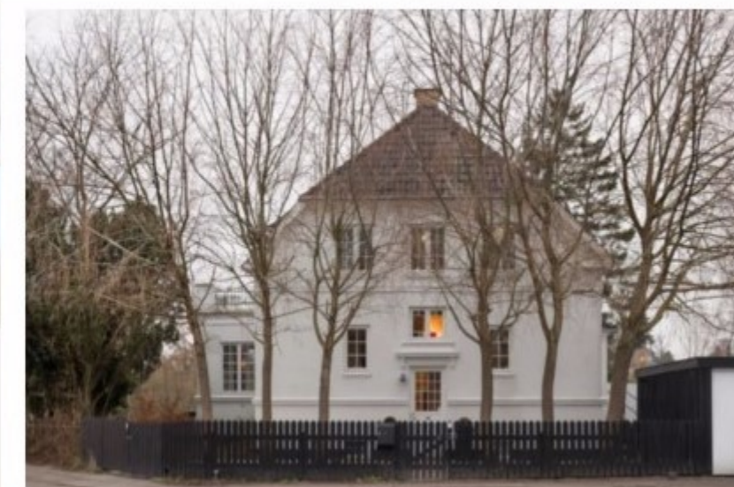
Set ude fra vejen vidner den klassiske gamle muremestervilla om en svunden tid, hvor afvalmede gavle, hvidpudsede facader, gesimser, balkoner og sprossede vinduer og døre – samt enkelte vinduer med farvet glas – var udbredt.
